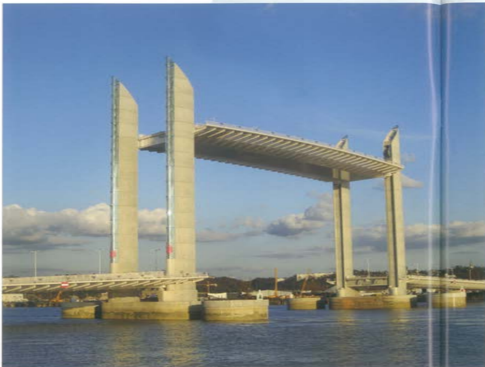
→ Chaban-Delmas brug, Bordeaux (doorvaartbreedte 106 m, hoogte 53 m)
